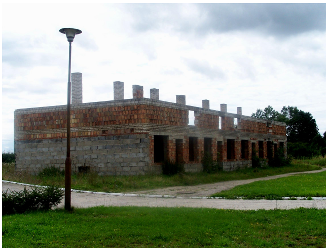
Rys. 8 Ruiny niedokończonej budowy budynku mieszkalnego
